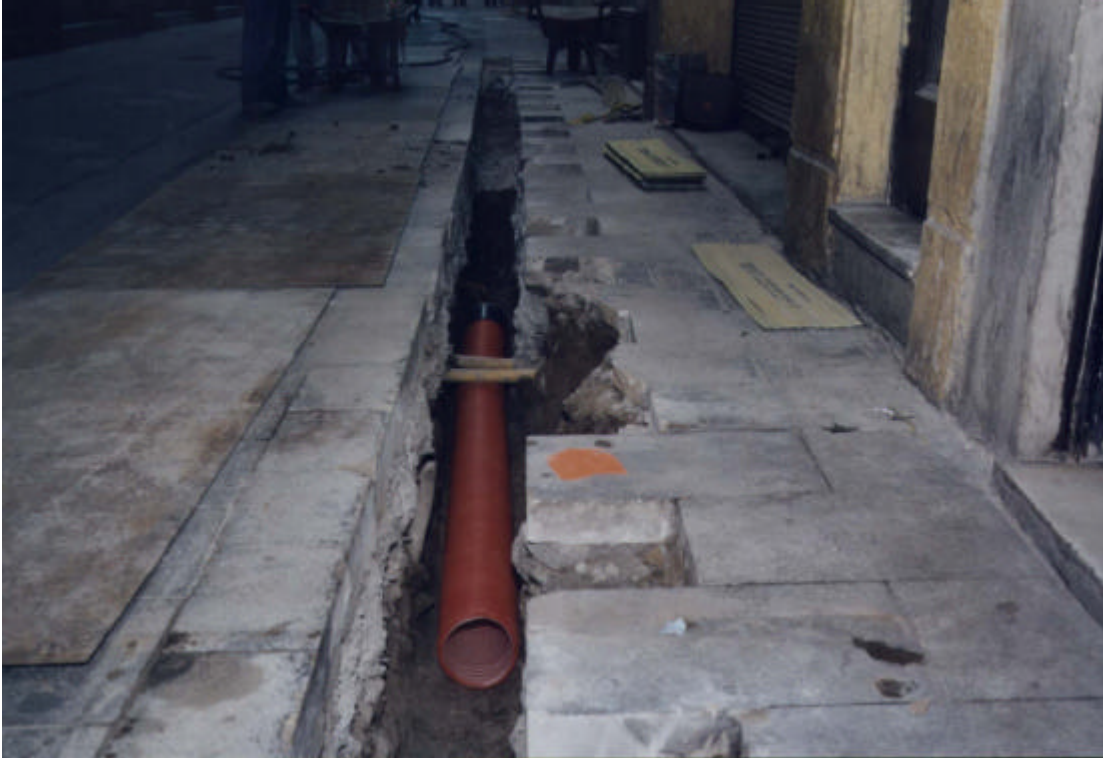
Fotografia 3: Canalització tubular subterrània dels cables elèctrics
